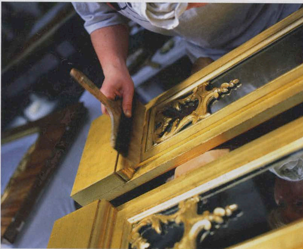
Patine de finition sur des parclores dorées en plein sur un chantier à Prague.
