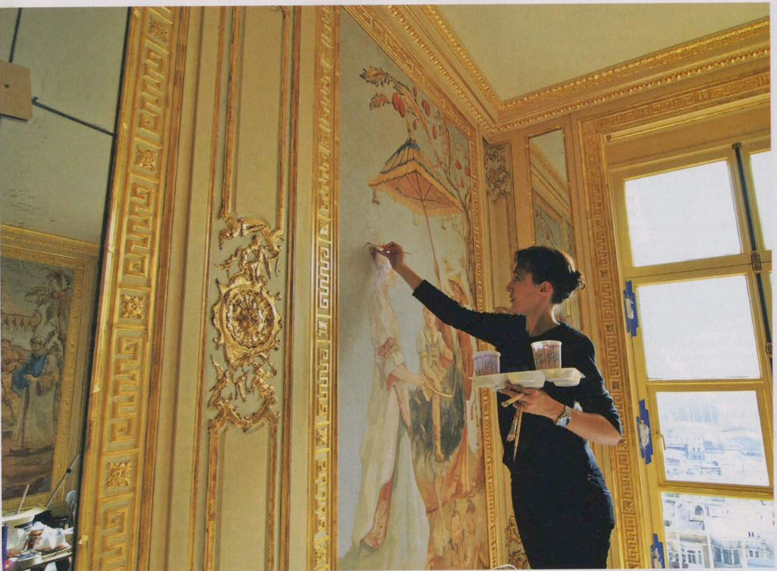
San Francisco : Stéphanie de Ricou effectue les derniers calages sur les toiles qui ont été enchâssées dans les boiseries peintes et dorées à l'atelier (boiseries Féau).
